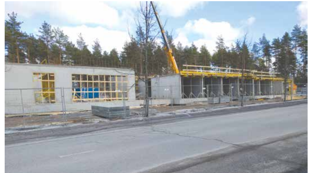
Uuden vanhusten palvelutalon rakennustyöt etenevät aikataulussa.
