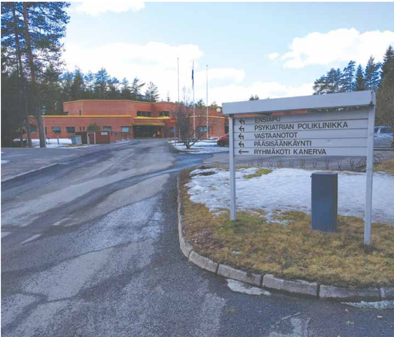
Terveyskeskusta odottaa yli 10 miljoonan euron remontti.
